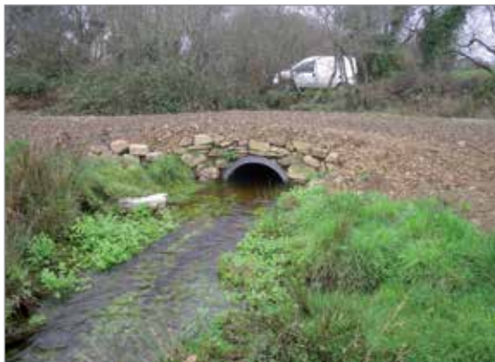
Illustration du type de travaux réalisés dans le cadre de la boucle vertueuse : création d'un passage au-dessus d'un petit cours d'eau.
