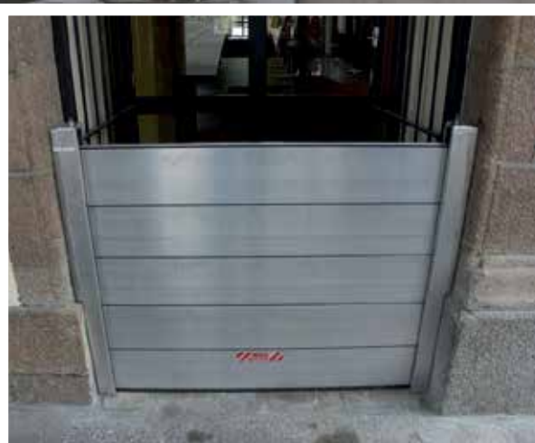
Batardeau à l'hôtel de ville de Morlaix.
